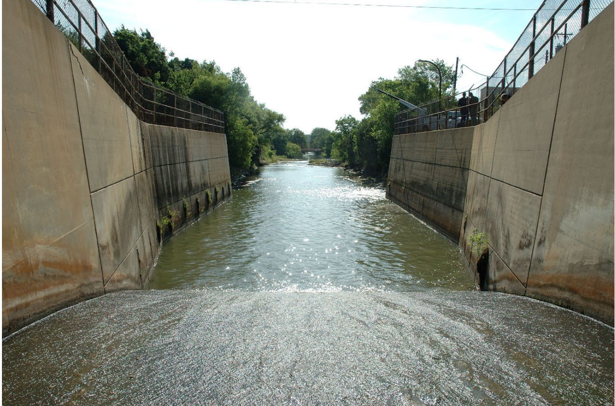
Grapevine Lake spillway (USACE photo)
